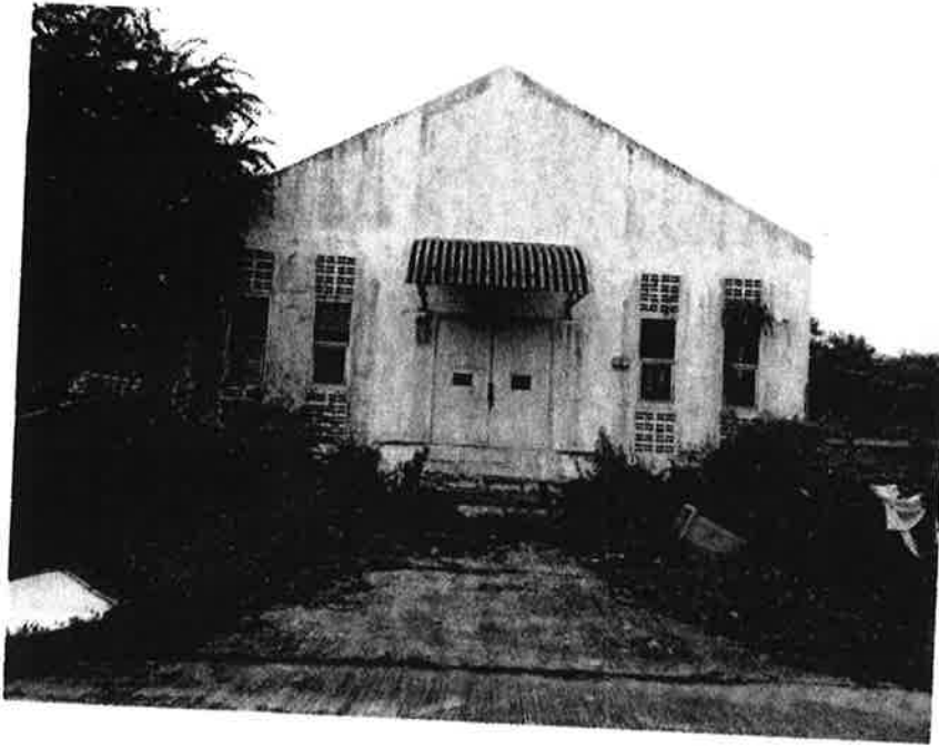
สถานที่ : อาคารโรงไฟฟ้า 2
